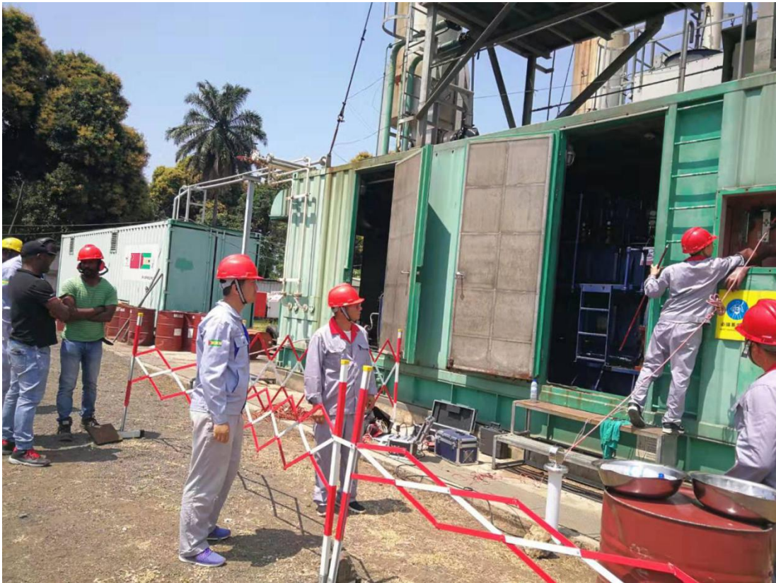
中国援圣普电力组开展设备维修
