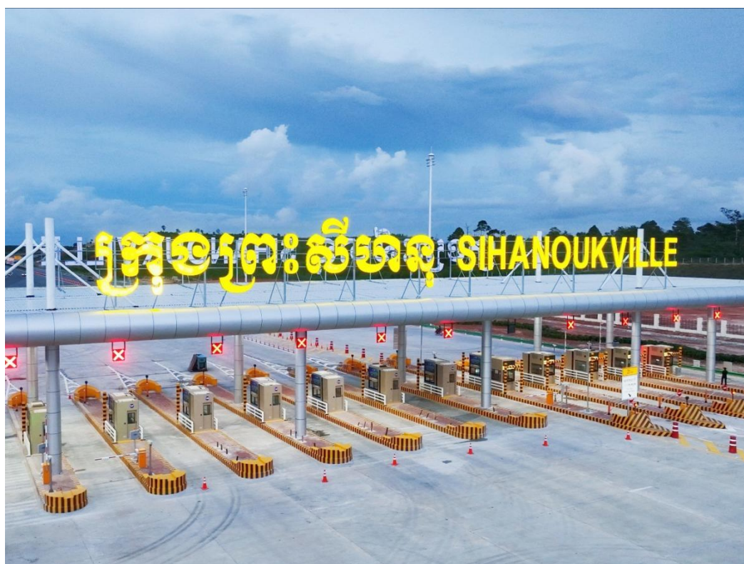
金边—西哈努克港高速公路收费站
