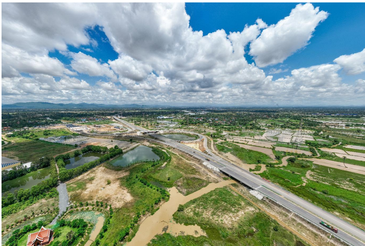
金港高速公路
