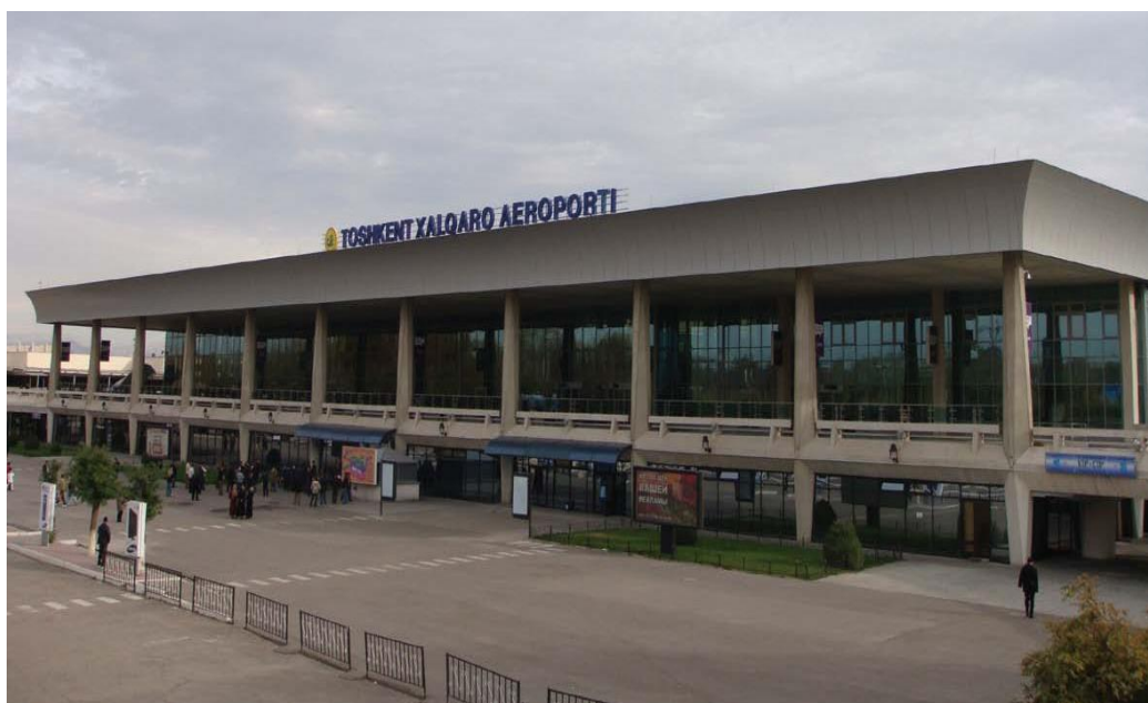
塔什干国际机场
