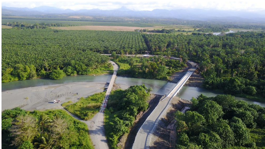
中国港湾公司承建的洪灾桥梁恢复项目
