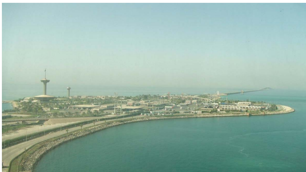
巴林沙特跨海大桥及海中人工岛
