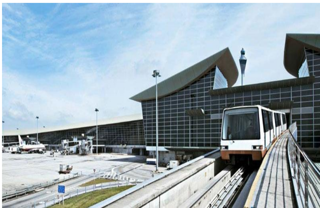
吉隆坡国际机场
