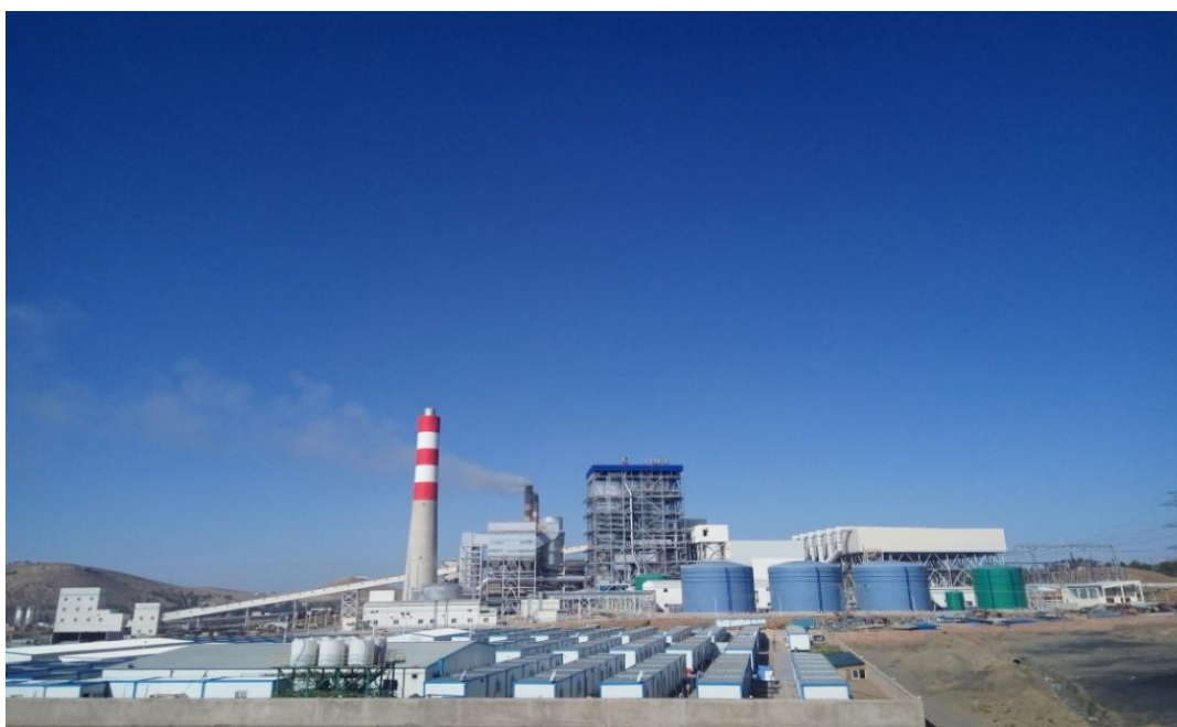
山东三建承建的杰拉达火电站项目
