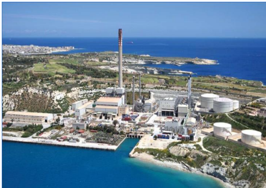
上海电力马耳他D3电厂
