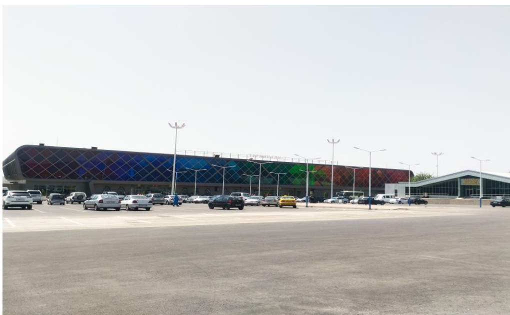
杜尚别机场新航站楼
