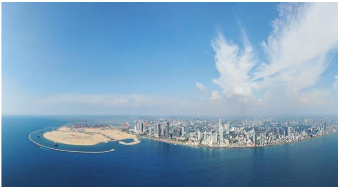
科伦坡港口城
