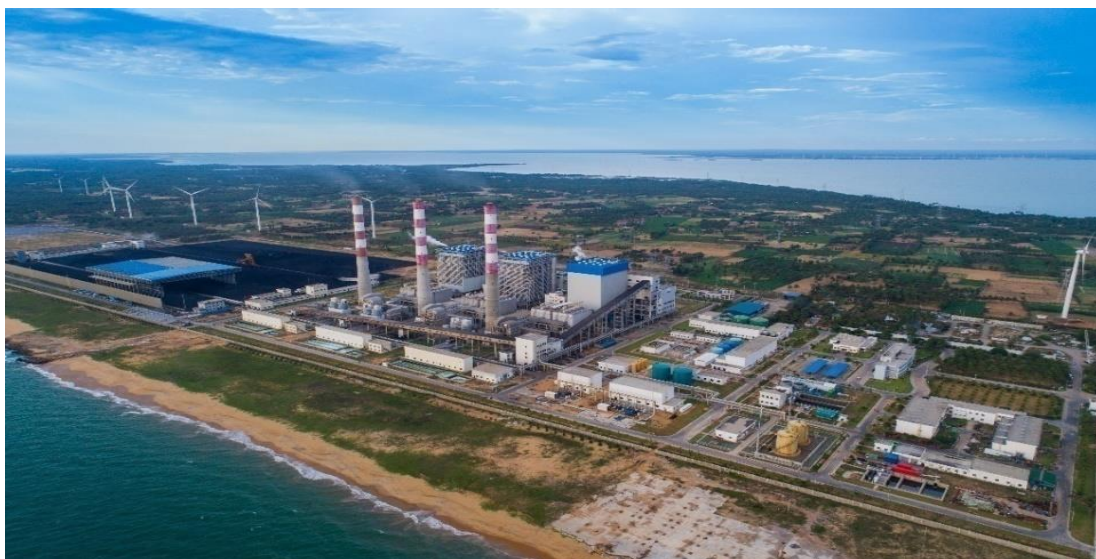
普特拉姆燃煤（Lakvijaya）电站
