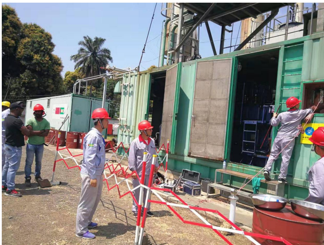
中国援圣普电力组开展设备维修
