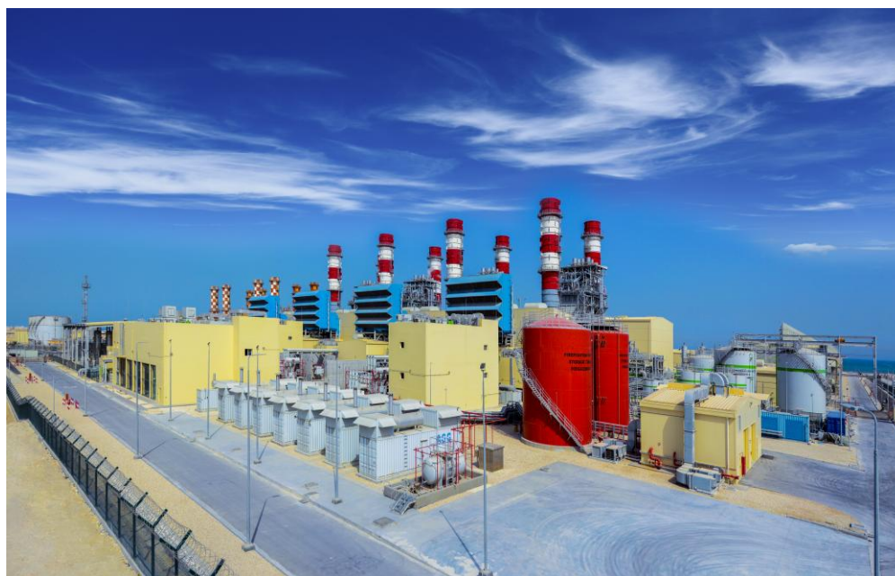
巴林阿杜尔电站二期1540兆瓦燃机电站项目
