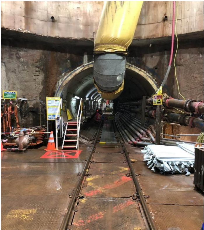
上海隧道在建项目
