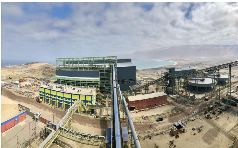
首钢秘铁二期扩建工程投入使用
