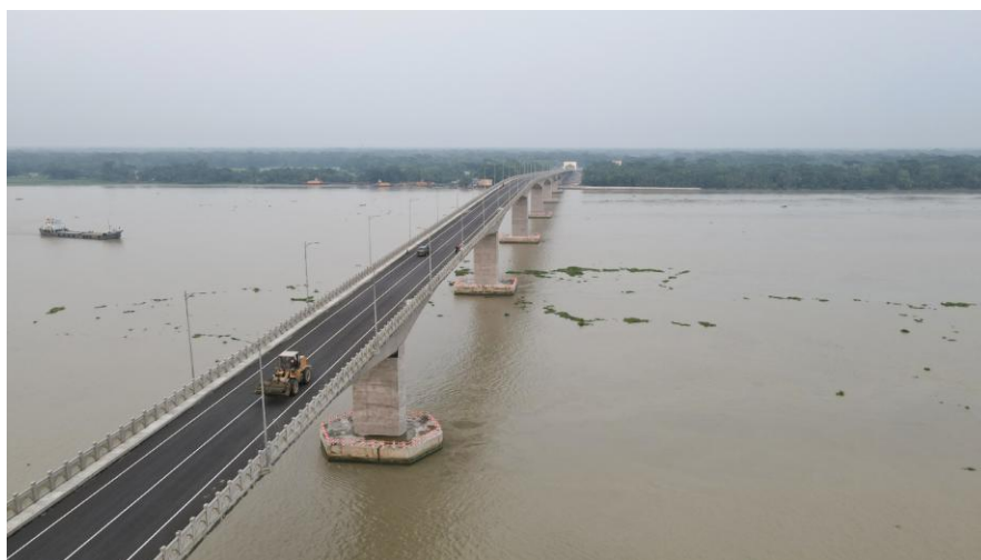
已经建成的友谊八桥项目
