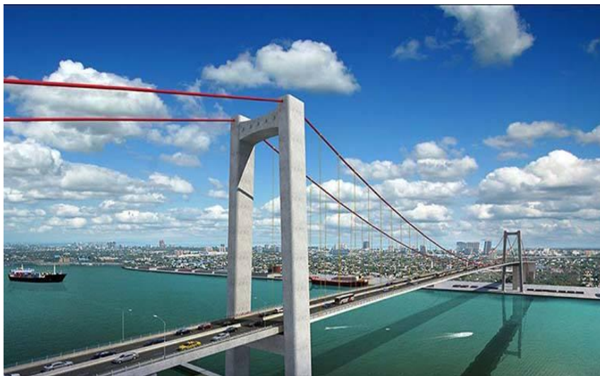
莫桑比克马普托-卡腾贝跨海大桥
