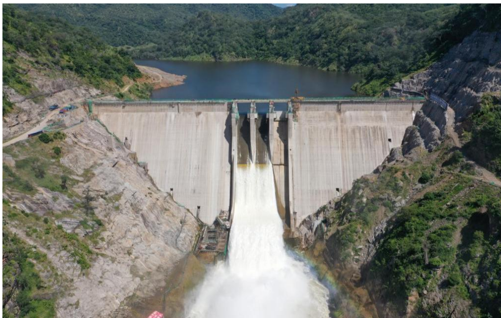
下凯富峡水电站大坝
