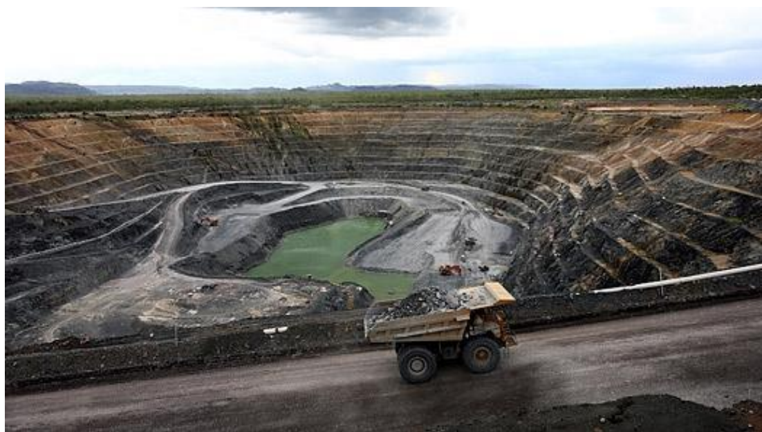
塔温陶勒盖煤矿露天开采现场
