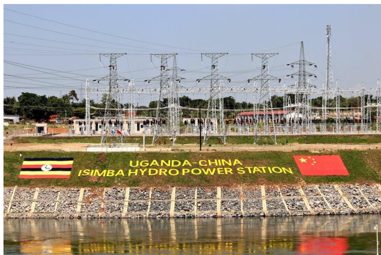
伊辛巴水电站
