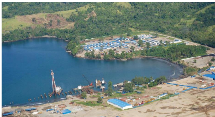
瑞木镍钴矿项目现场
